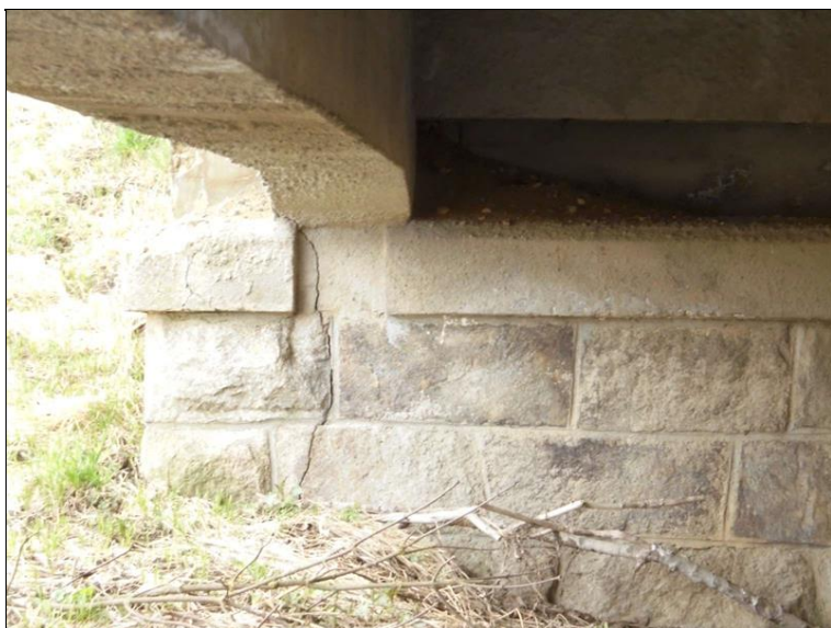
Svislá trhlina ve zdivu OP1 pod pravým krajním trámem.
