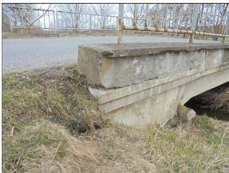
Viditelná hrana původní a nadbetonované římsy na konci mostu vlevo.
