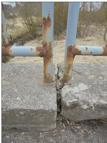
Rozevřené a neutěsněné spáry v dilatacích říms.
